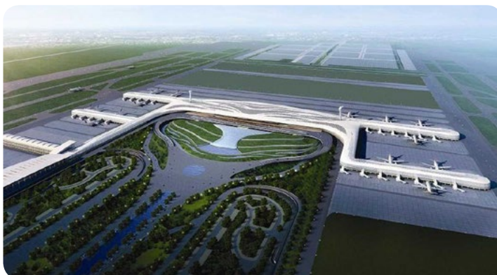
武汉天河机场 T3 航站楼
